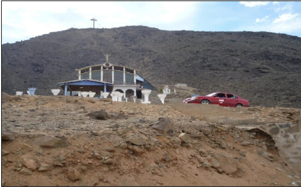
Figura 45: Caída de rocas de origen ígneo en el ascenso al cerro La Juventud
