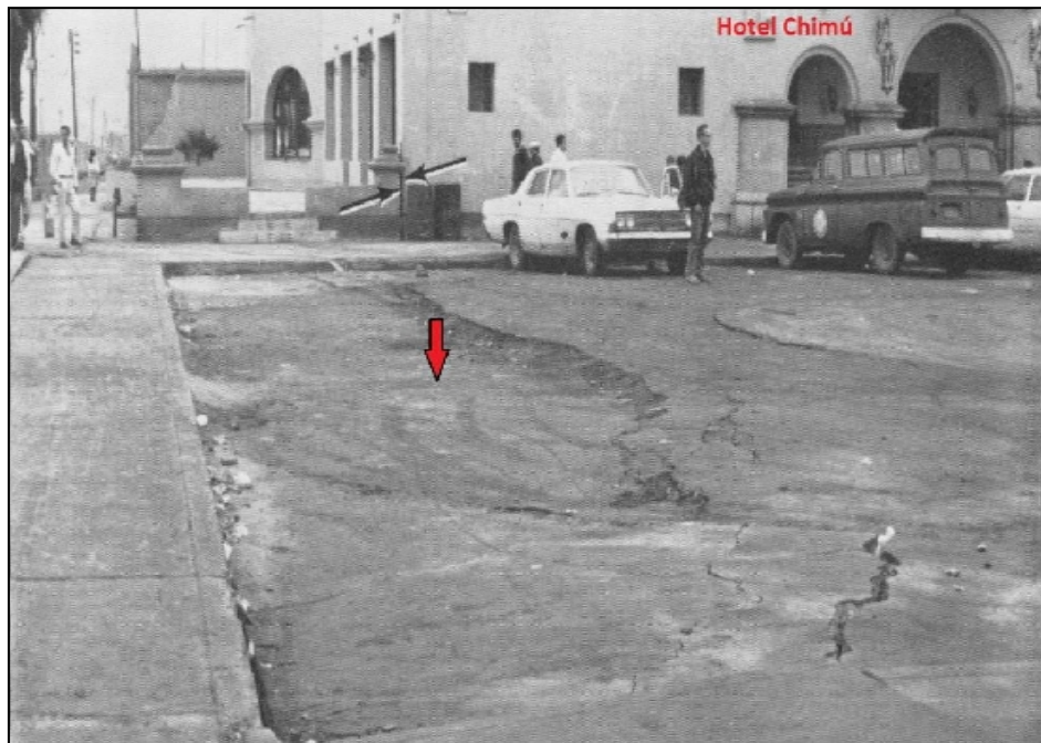
Figura 48: Inmediaciones del Hotel Chimú y suelos con asentamientos diferenciales debido a proceso de licuación de suelos a causa del sismo de 1970.
