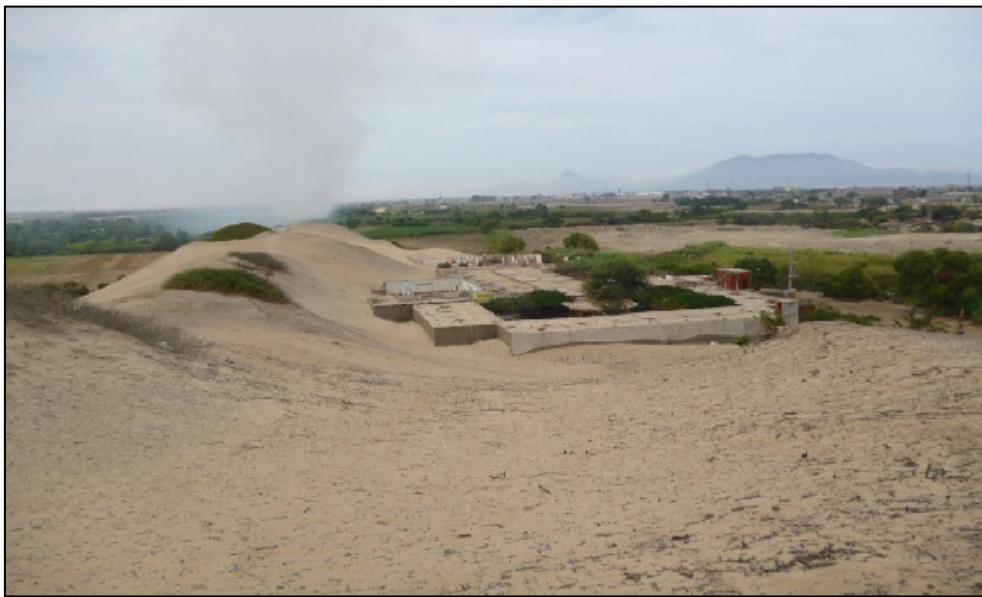
Figura 51: Viviendas ubicadas cerca del cerro Tres Cabezas. Observe como los depósitos eólicos han sobrepasado la altura de las casas.
