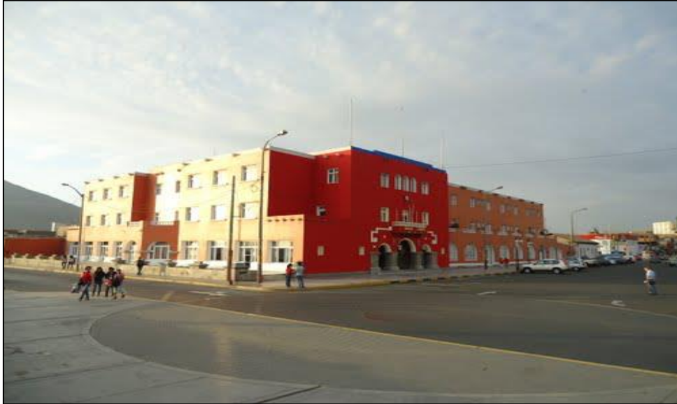
Figura 49: Frontis del Hotel Chimú, año 2013. Observese suelos sin asentamientos del terreno.
