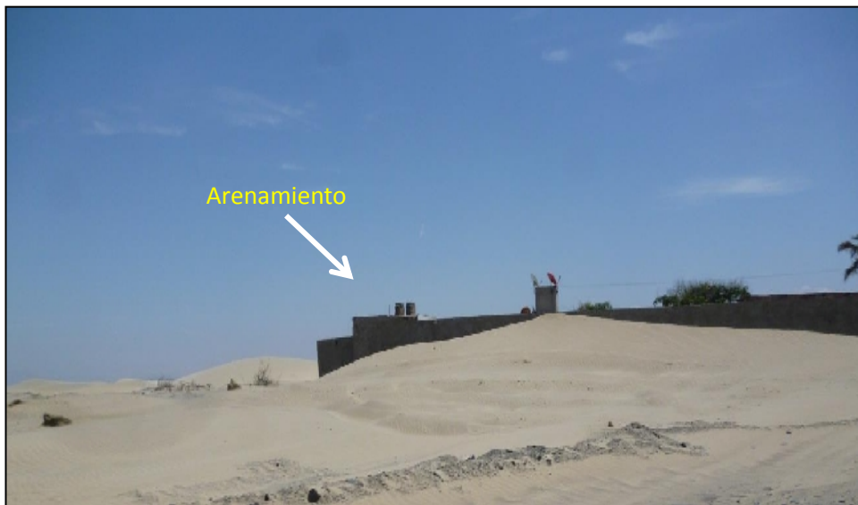
Figura 28: Las arenas eólicas varían rápidamente su geoforma y logran invadir zonas pobladas como es el caso de los muros del aeropuerto.
