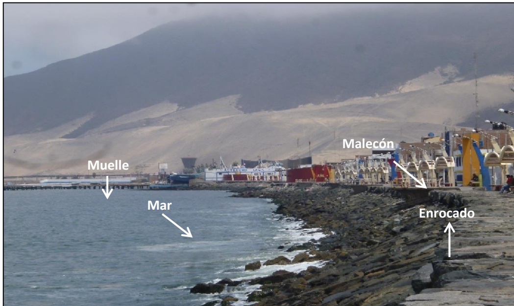
Figura 32: En las playas se ha construido muros de rocas como medida ante la erosión marina.
