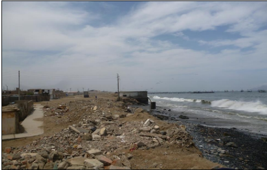
Figura 50: Erosión marina frente al AAHH Miramar Bajo. Los escombros se encuentran formando barreras, situación que no corresponde a una solución técnica al problema.
