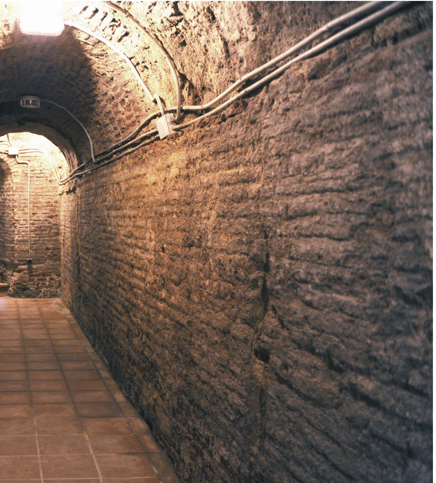
Interior de la antigua alcantarilla de la Cava Baja de San Francisco, en el antiguo palacio de los Marqueses de Villafranca
