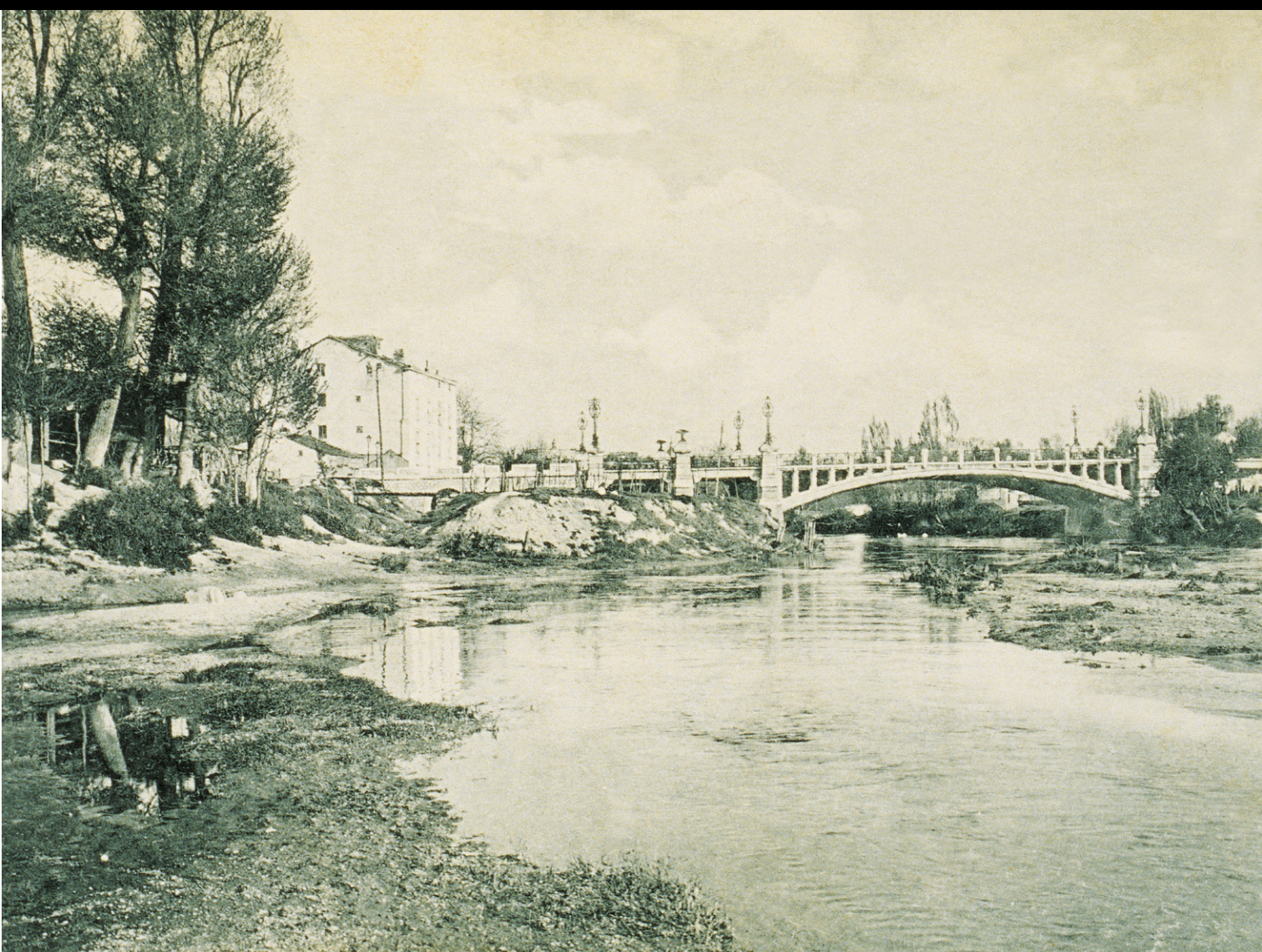
PUENTE DE LA REINA Construcción original 1908-1909
