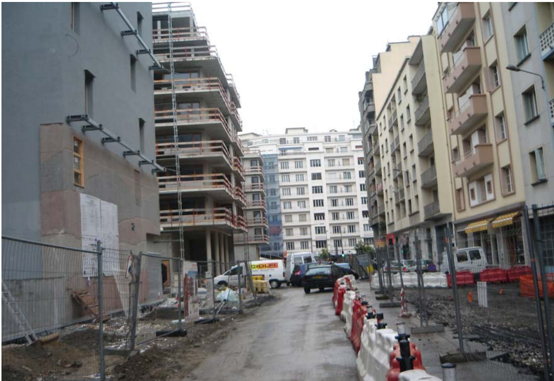
La ZAC en chantier © Jacotte Bobroff
