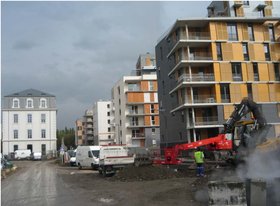
La ZAC en chantier © Jacotte Bobroff
