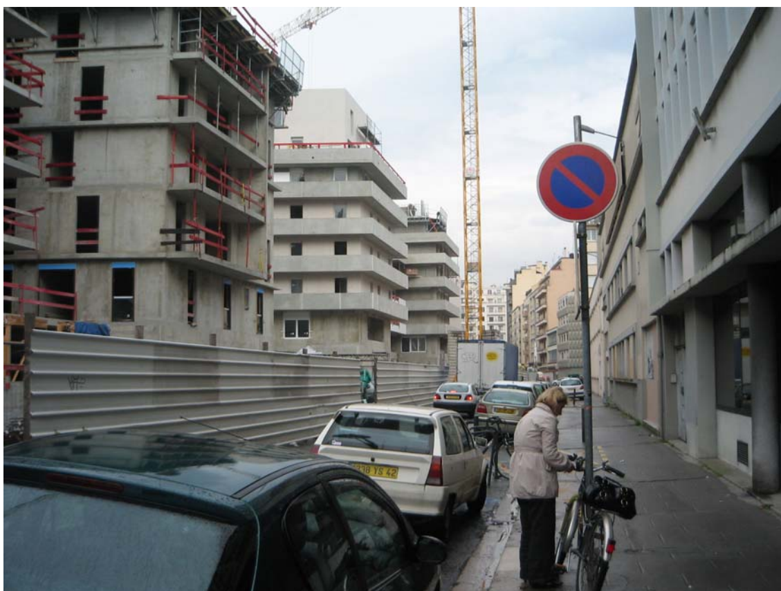
La ZAC en chantier © Jacotte Bobroff
