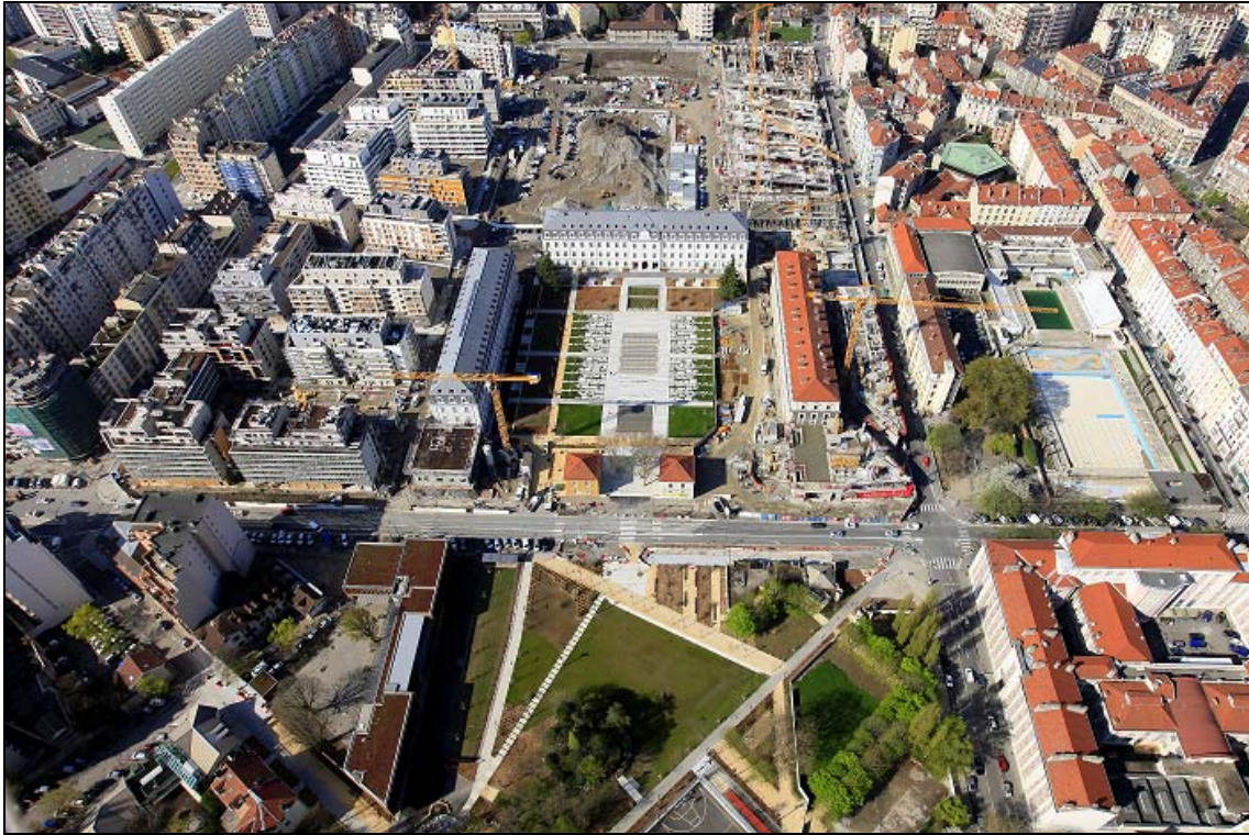
Vue aérienne de la ZAC de Bonne en chantier © Christian Devillers
