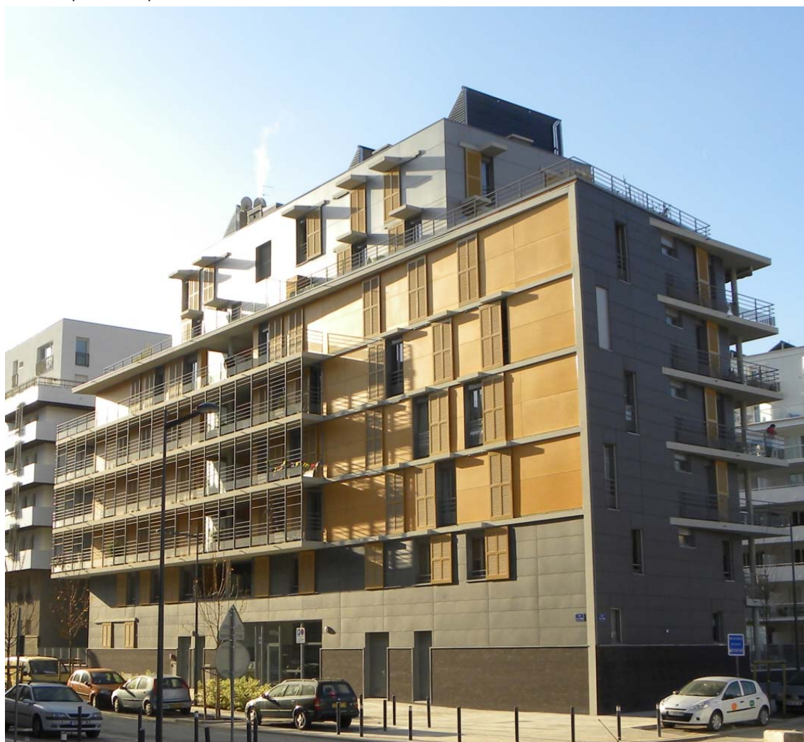
Résidence de 27 logements en accession Bernard Teillaud – architecte Brenas-Doucerain - © SEM SAGES
