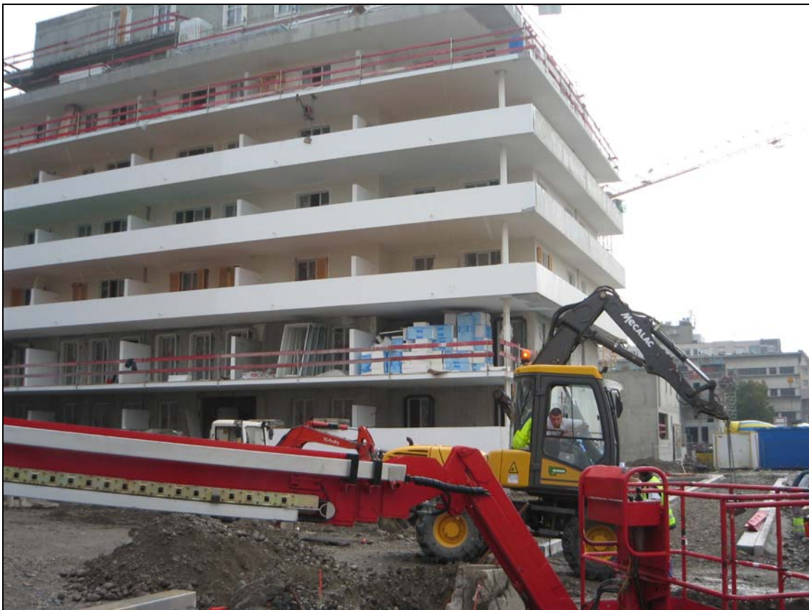
La ZAC en chantier © Jacotte Bobroff
