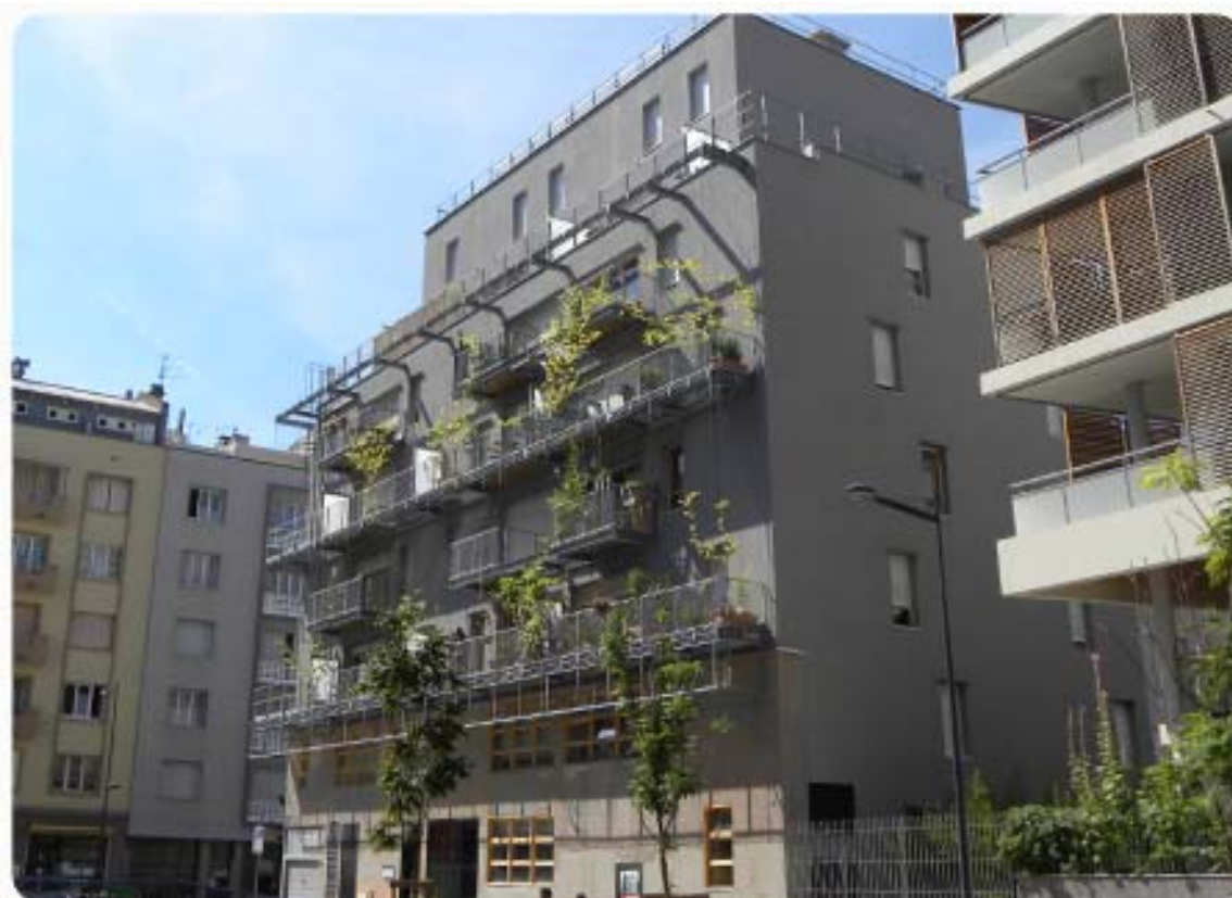
L'opération de 17 logements en accession sociale de Dauphilogis – Architecte Edouard François © SEM SAGES
