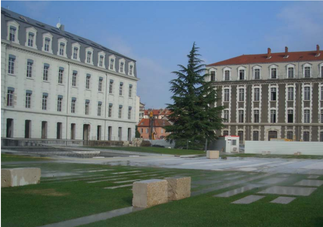
Les bâtiments de la caserne restaurés © SEM SAGES
