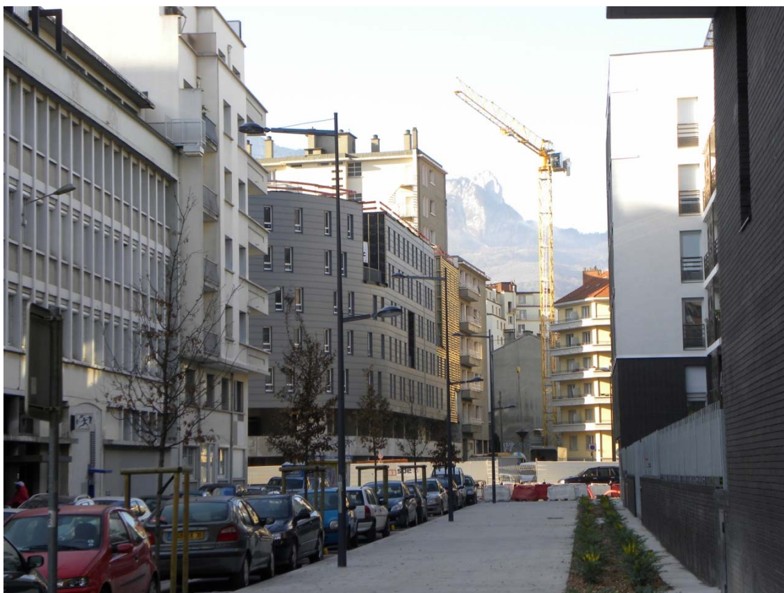
Résidence étudiante de 74 logements (bâtiment arrondi en gris) de Grenoble Habitat © SEM SAGES
