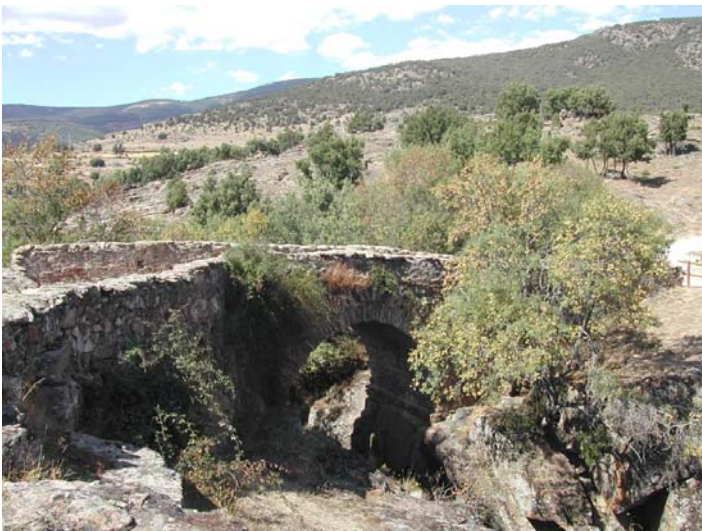
Figura 26: Aspecto del puente medieval del Congosto, construido con gneis sobre el río Lozoya y cimentado sobre gneis .
