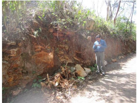
**Fotografía 63.** Caída de suelo y rocas (punto YPRM22), afectando a la vía de comunicación, debido las precipitaciones pluviales recientes.
