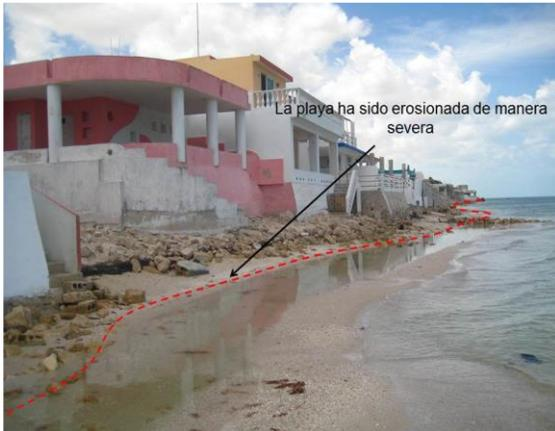
**Fotografía 163.** En Chelem, municipio de Progreso, el espesor de playa ha sido totalmente erosionado, dejando a las viviendas en el límite con el mar.
