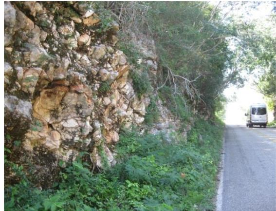
**Fotografía 59.** Talud sobre camino pavimentado con flujo constante de vehículos (punto YPRM04), el macizo rocoso se encuentra altamente fracturado, lo que provoca pequeños bloques que caen sobre el camino.
