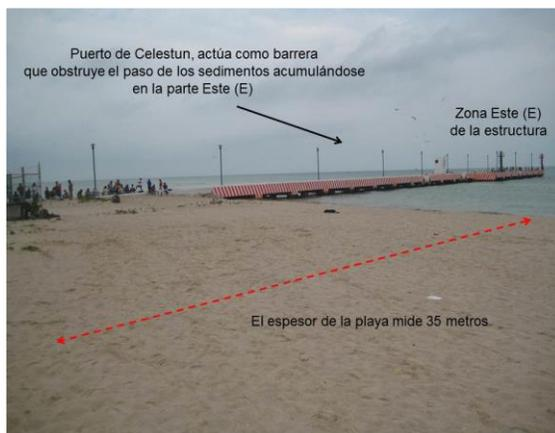
**Fotografía 151.** Puerto de Celestún, impide que pase la arena de manera natural, acumulándola en la parte Este (E) de la estructura llegando a medir hasta 35 metros.
