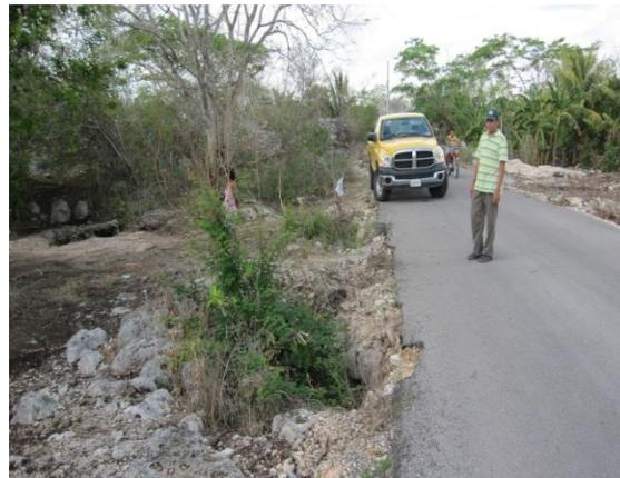
**Fotografía 84.** Colapso en superficie provocado por cavidad en el subsuelo. Santa María Acu. Municipio de Halachó.
