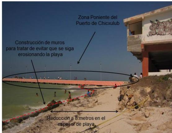
**Fotografía 162.** En Chicxulub Puerto, municipio de Progreso, evidente problema de erosión debido principalmente a la construcción del muelle ya que no permite el paso al lado poniente de la estructura.
