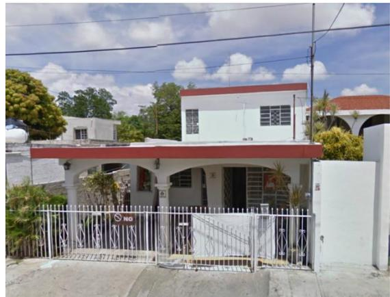
**Fotografía 6.** Vivienda tipo III construida con paredes de material rígido y techo de lámina o teja.
