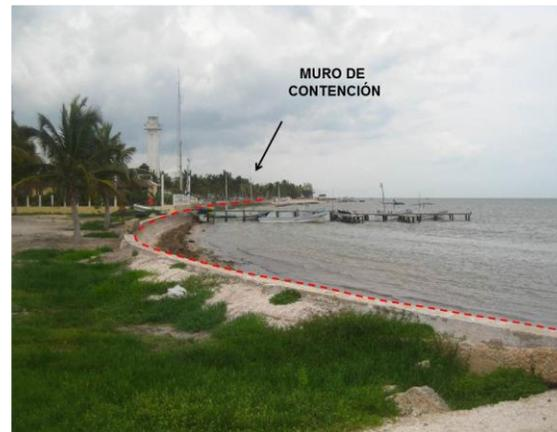
**Fotografía 175.** En la Cabecera Municipal de Dzilam de Bravo, se construyó un muro de contención sobre la línea de costa, con el objetivo de mitigar inundaciones cuando aumenta el nivel del mar principalmente en época de huracanes o tormentas tropicales.
