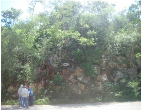
**Fotografía 58.** Carretera Uxmal (YPRM01), cerca de la localidad de Calcehtok, se encuentra un talud de 5 m de altura, roca caliza con sistemas de fracturamiento, dentro de las fracturas se encuentra rellena de suelo de color rojizo, en esta zona se observó una brecha de falla.
