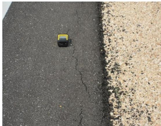
**Fotografía 94.** Carpeta asfáltica recién construida con presencia de fracturas.
