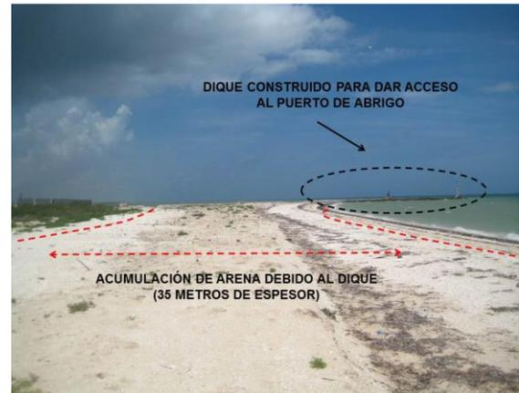
**Fotografía 171.** En Laguna Rosada, municipio de Telchac Puerto, la construcción del dique genera acumulación de arena al lado oriente de dicha estructura creando erosión al lado contiguo de la misma.
