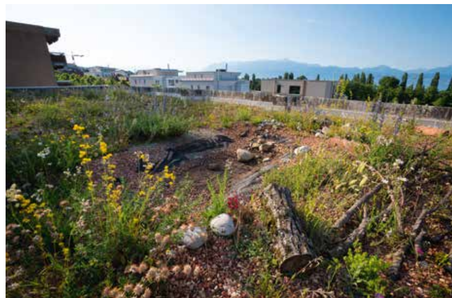
| Avenue des Figuiers, Lausanne ; toit végétalisé |
